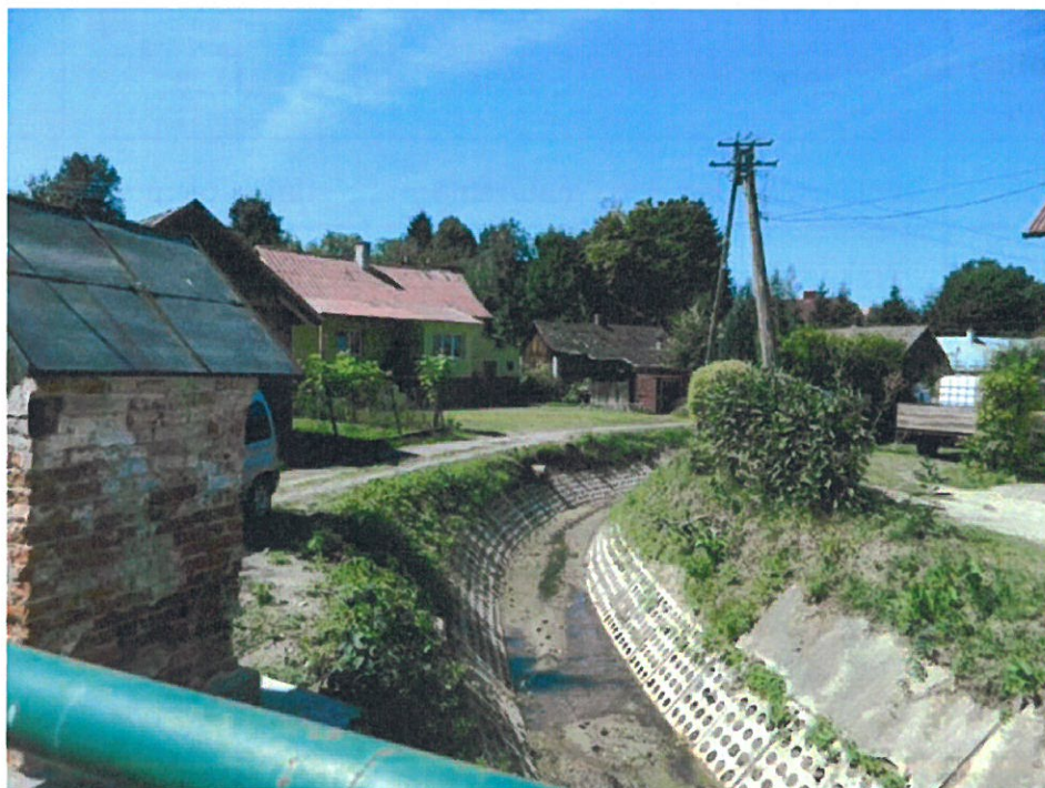
Fot. 2 Oczyszczony rów melioracyjny w miejscowości Malawa 26
